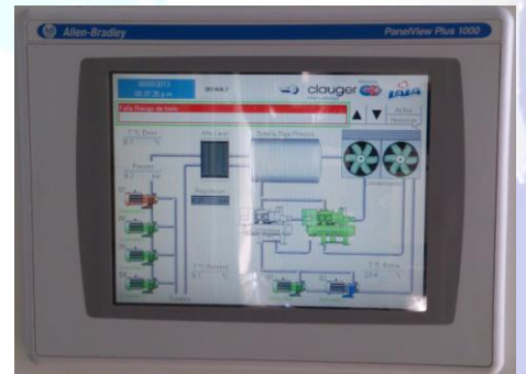
Réalisation d'une salle des machines pour l'envoi d'eau glacée
