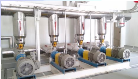
Réalisation d'une salle des machines pour l'envoi d'eau glacée
